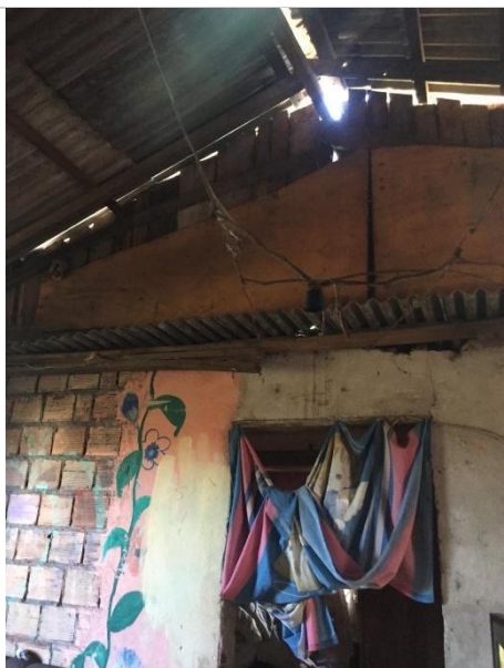
Cobertura e Revestimentos
