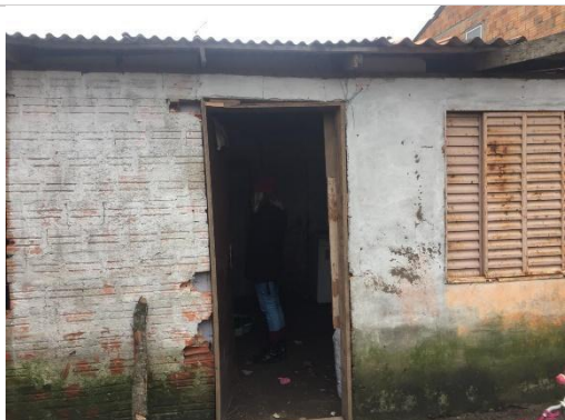
Cobertura e Revestimentos
