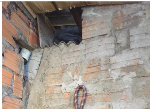
Cobertura e Revestimentos
