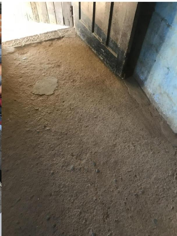
FIGURAS 20 – INADEQUAÇÃO DE PISO - CONTRA PISO PARCIAL (ESQ.) E TOTAL (DIR.)
