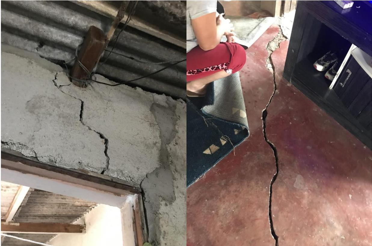
FIGURAS 26 – OUTRAS INADEQUAÇÕES - PROBLEMAS ESTRUTURAIS - TRINCAS EM PAREDES E PISO
