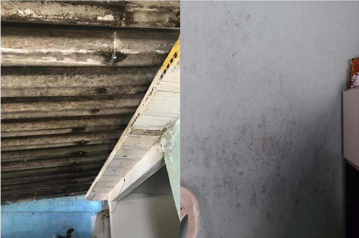
FIGURAS 05 – Precariedades comuns - Telhas de amianto em situação precária (esquerda) e umidade/ infiltração nas paredes (direita).
