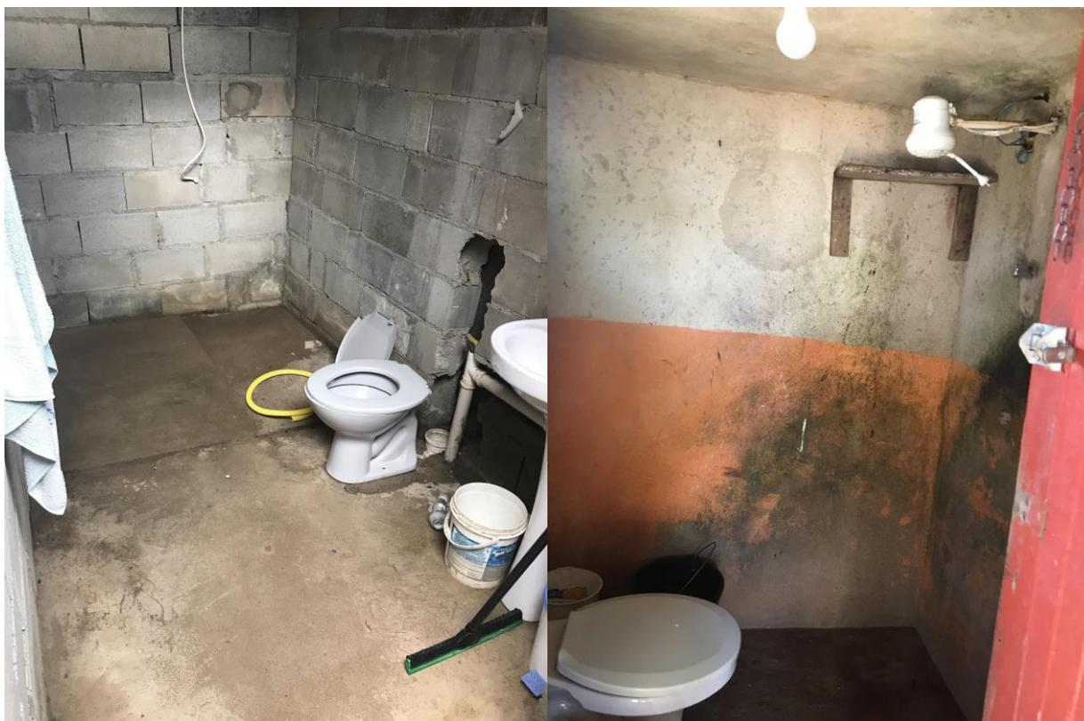
FIGURAS 23 – INADEQ. DE BANHEIRO - SEM REVESTIMENTO DE PISO E ALVENARIA E COM UMIDADE
