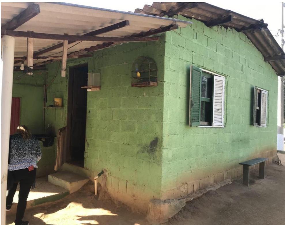
FIGURA 15 – Precariedades comuns nas casas: fachada em alvenaria sem reboco e cobertura em telhas de amianto.
