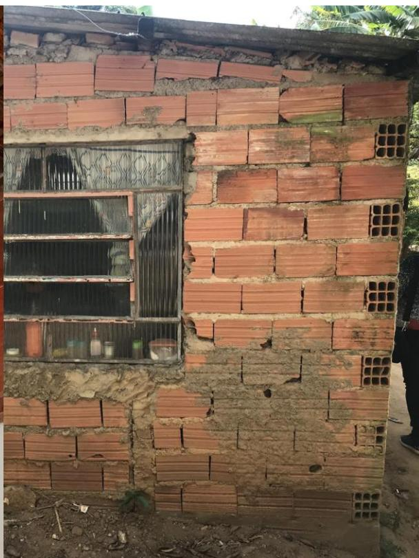
FIGURAS 21 – INADEQUAÇÃO DE REVESTIMENTO - ALVENARIA SEM REBOCO AMB. INTERNO E FACHADA
