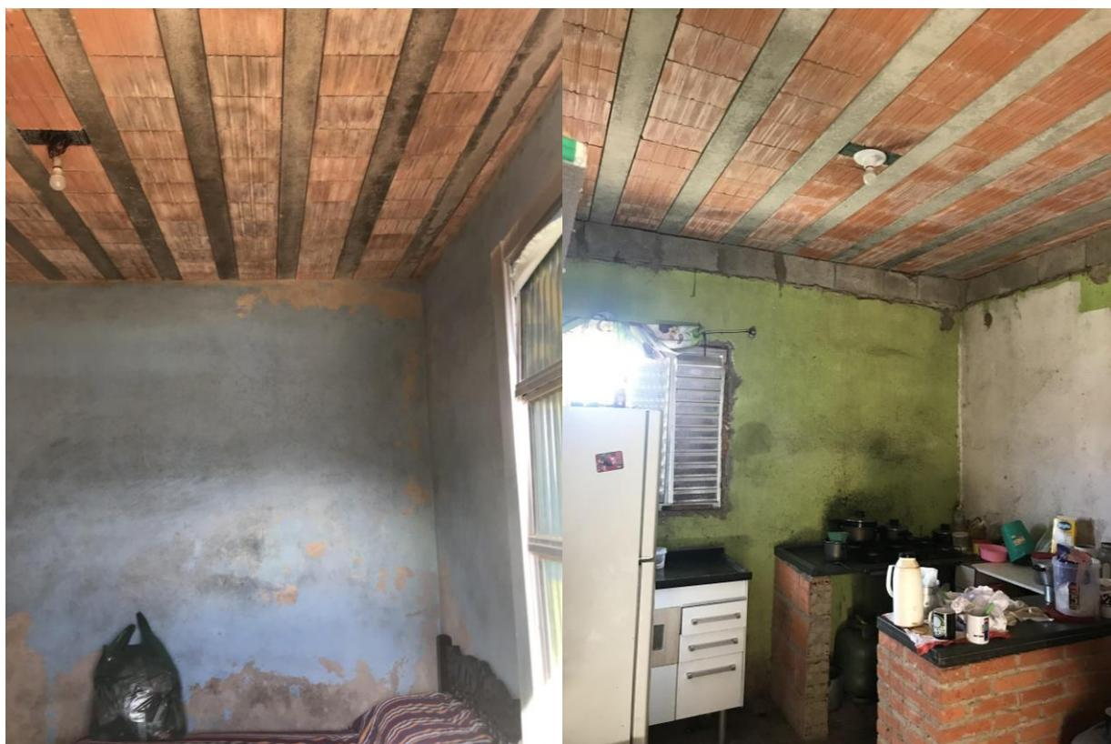
FIGURAS 12 – Subárea 2 - Infiltrações nas paredes e lajes
