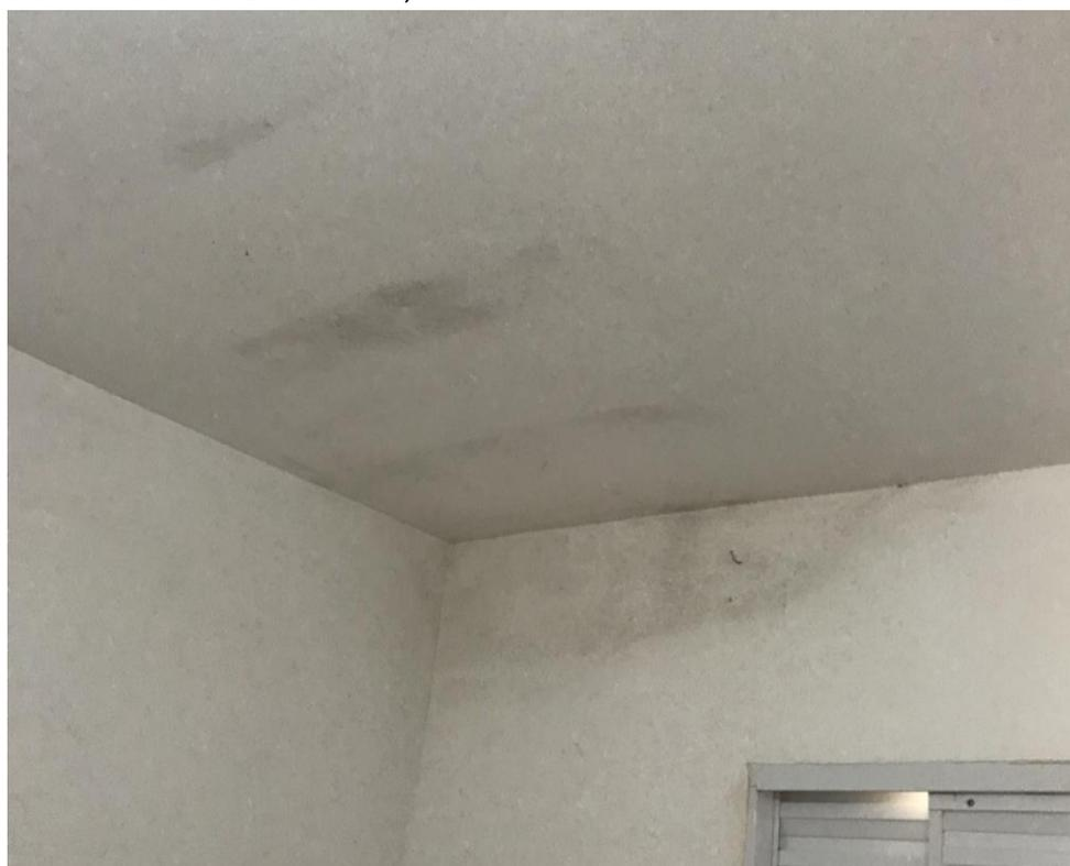
FIGURAS 10 – Subárea 1 - Infiltração na laje (inf.)
