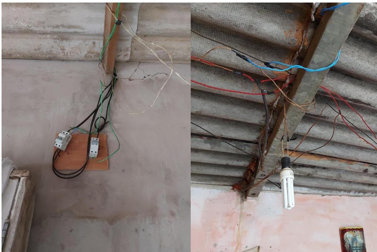
FIGURAS 24 – OUTRAS INADEQUAÇÕES - SISTEMA ELÉTRICO EXPOSTO
