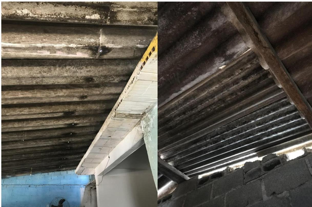
FIGURAS 22 – INADEQ. DE COBERTURA - COBERTURAS EM TELHA DE AMIANTO E COM VAZAMENTOS
