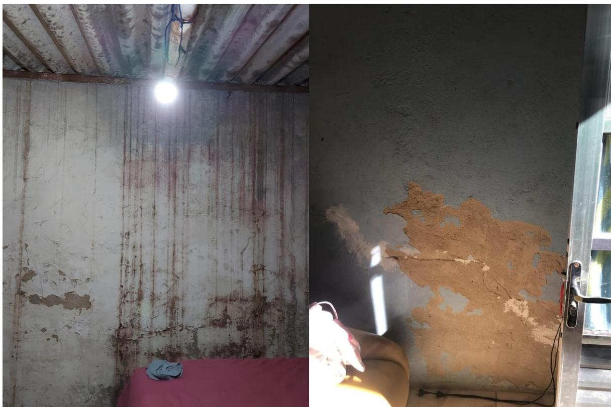
FIGURAS 25 – OUTRAS INADEQUAÇÕES - UMIDADE E INFILTRAÇÕES NO TETO E PAREDES
