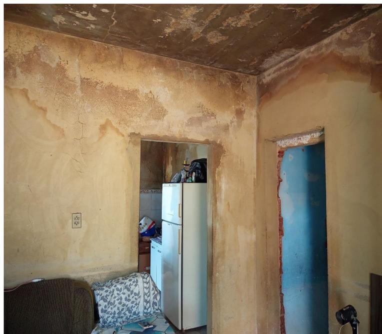
Foto: Sala com parede e teto com marcas de mofo e infiltração proveniente da ausência de telhado
