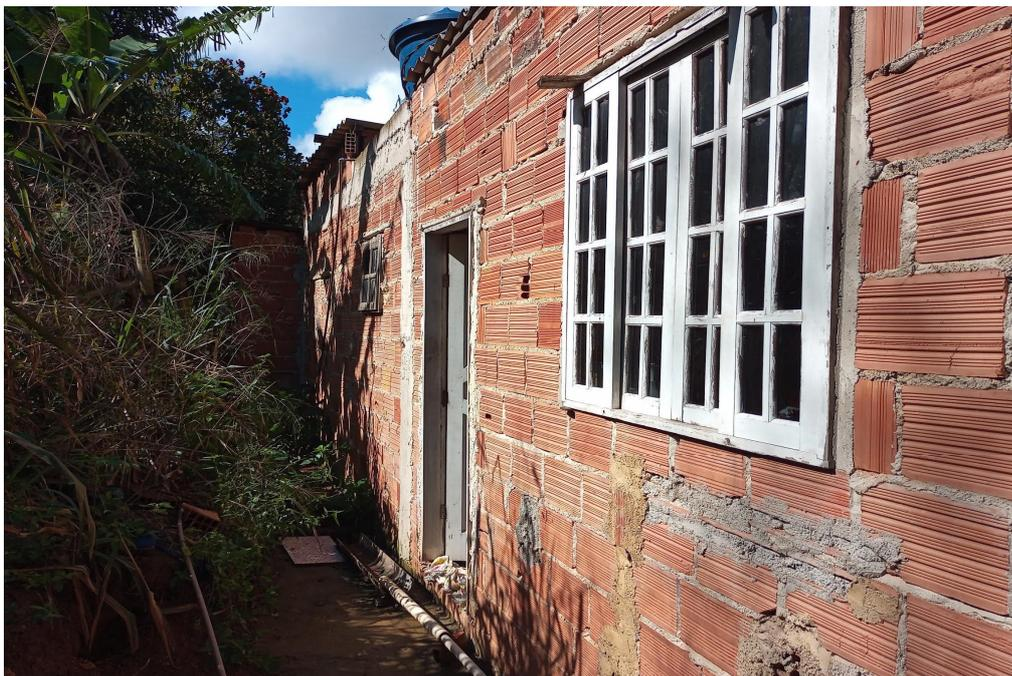
Foto: Fachada sem revestimento de reboco e despejo de esgoto a céu aberto.
