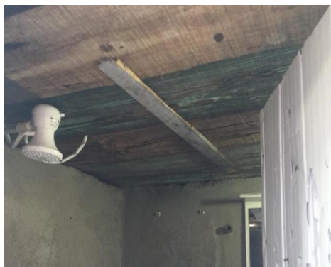
C. Revestimentos e Cobertura
